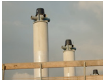
De innovatieve kolommen in aanbouw (foto Nadine Schellekens)
